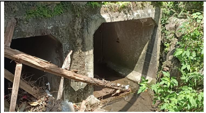
KONDISI BANGUNAN BAWAH BOX CULVERT
