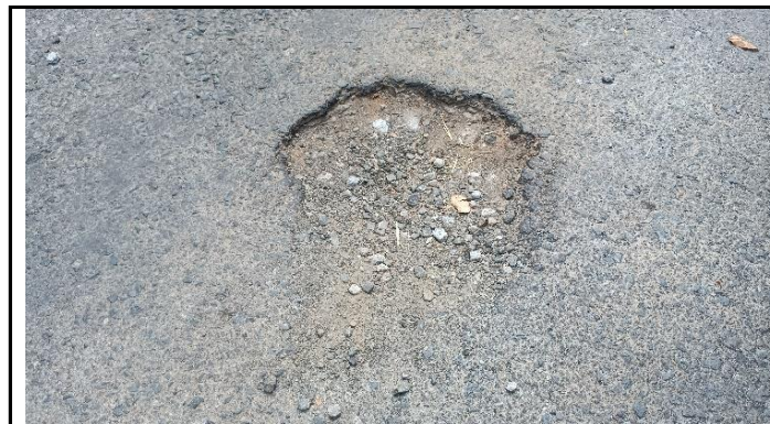
LAPISAN PERMUKAAN LANTAI BERLUBANG
