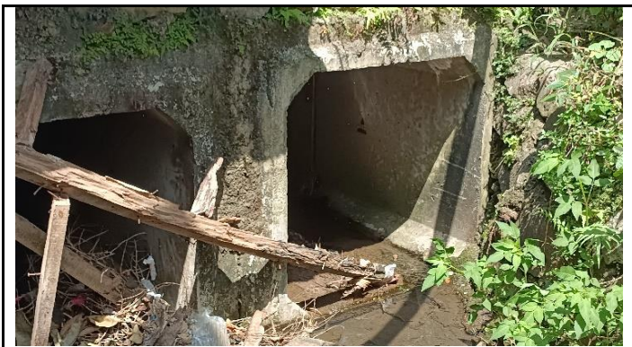
KONDISI BANGUNAN BAWAH BOX CULVERT
