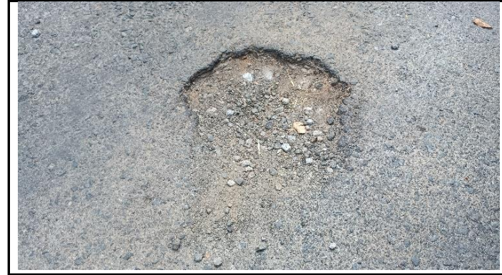
LAPISAN PERMUKAAN LANTAI BERLUBANG
