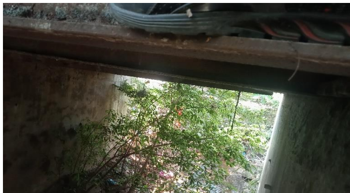
KONDISI BANGUNAN BAWAH
