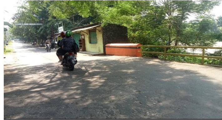
KONDISI LAPISAN PERMUKAAN LANTAI
