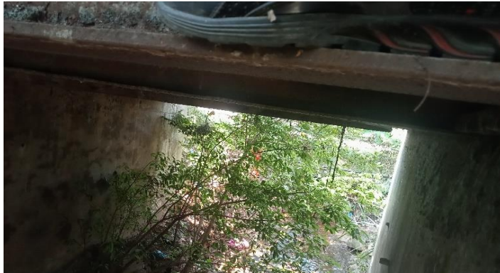
KONDISI BANGUNAN BAWAH
