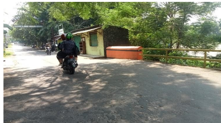
KONDISI LAPISAN PERMUKAAN LANTAI
