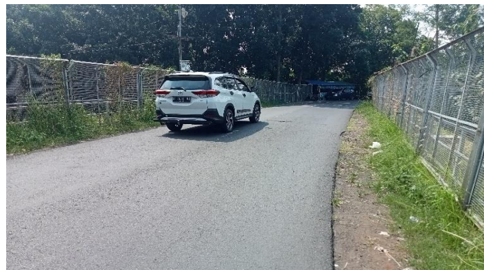
KONDISI LAPSIUSAN PERMUKAAN LANTAI
