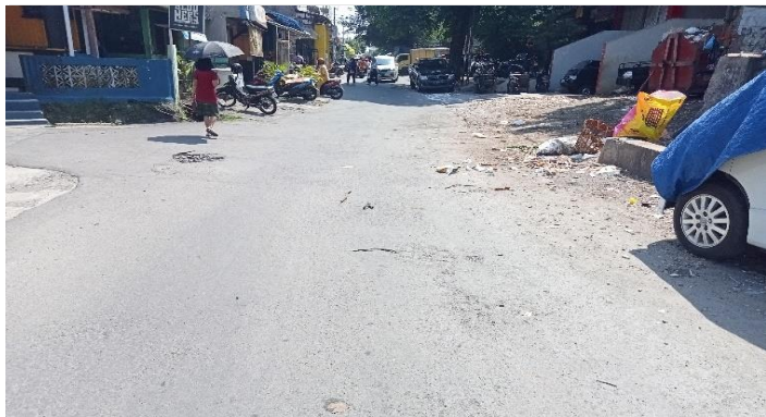
KONDISI LAPISAN PERMUKAAN LANTAI
