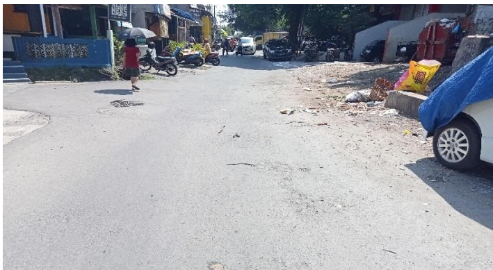
KONDISI LAPISAN PERMUKAAN LANTAI
