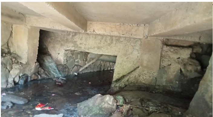
KONDISI BANGUNAN BAWAH
