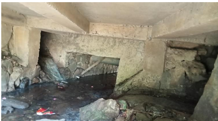
KONDISI BANGUNAN BAWAH
