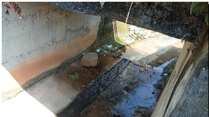
KONDISI BANGUNAN BAWAH
