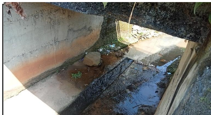
KONDISI BANGUNAN BAWAH
