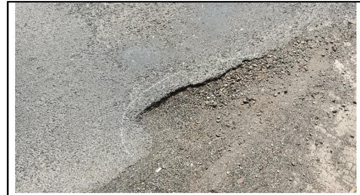
LAPISAN PERMUKAAN ASPAL BERLUBANG
