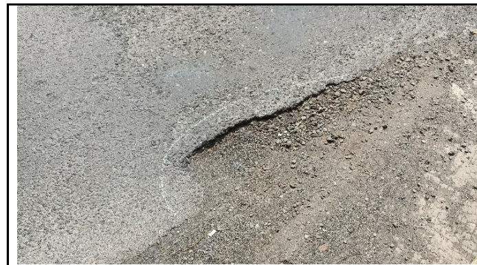
LAPISAN PERMUKAAN ASPAL BERLUBANG
