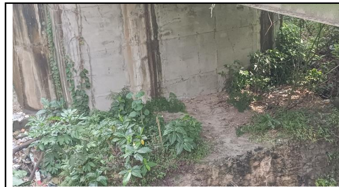
KONDISI KEPALA JEMBATAN
