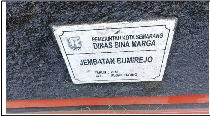
PAPAN NAMA JEMBATAN
