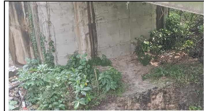
KONDISI KEPALA JEMBATAN
