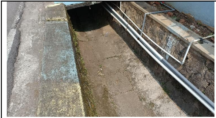
KONDISI PIPA UTILITAS AIR MINUM
