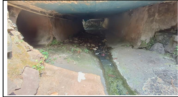
KONDISI BANGUNAN BAWAH
