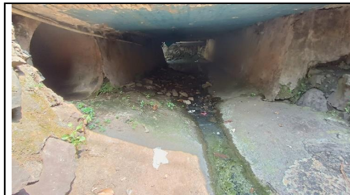
KONDISI BANGUNAN BAWAH
