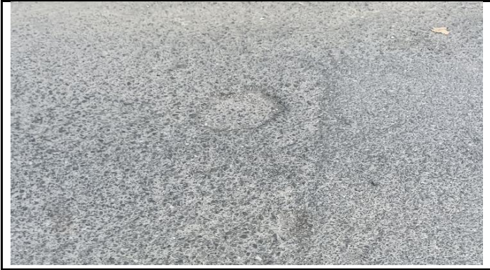
LAPISAN PERMUKAAN LANTAI BERLUBANG
