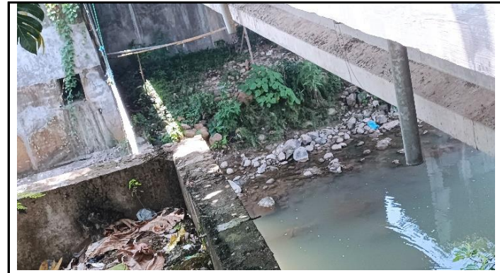
KONDISI GELAGAR DAN BANGUNAN BAWAH
