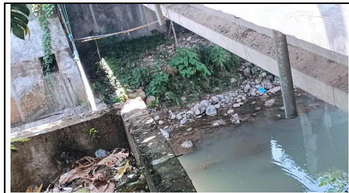
KONDISI GELAGAR DAN BANGUNAN BAWAH
