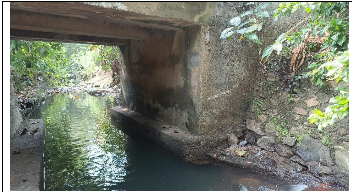
KONDISI KEPALA JEMBATAN
