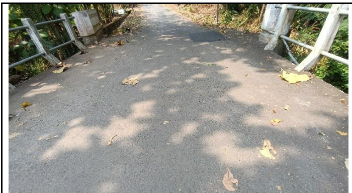
KONDISI LAPISAN PERMUKAAN LANTAI
