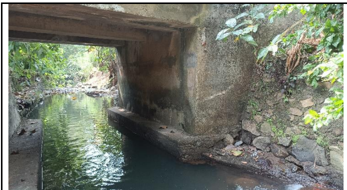
KONDISI KEPALA JEMBATAN
