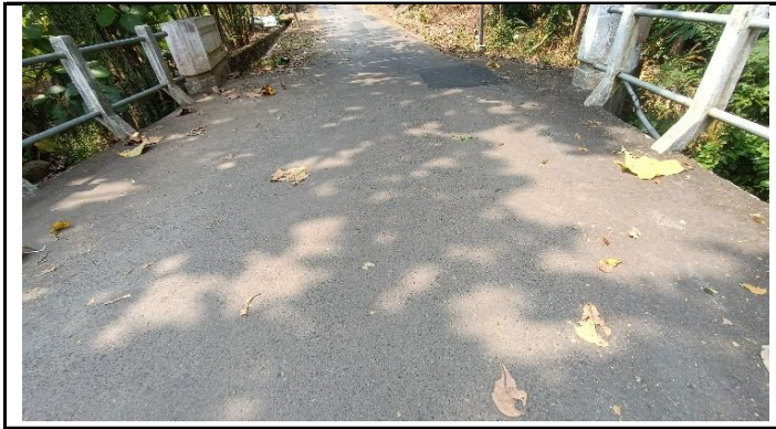
KONDISI LAPISAN PERMUKAAN LANTAI
