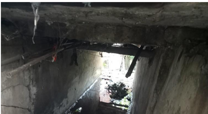
KONDISI BANGUNAN BAWAH
