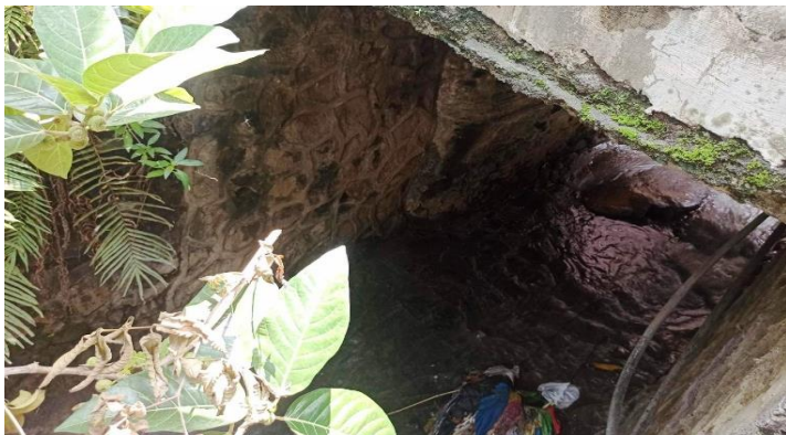
KONDISI BANGUNAN BAWAH
