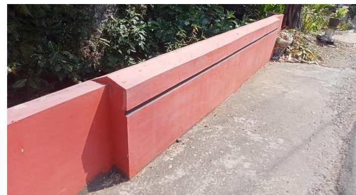
KONDISI TEMBOK SANDARAN
