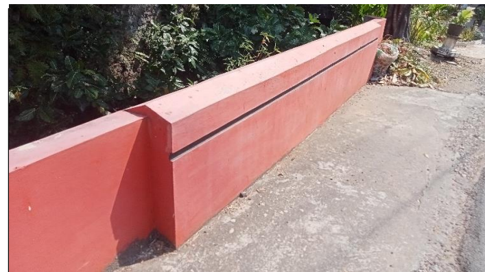
KONDISI TEMBOK SANDARAN
