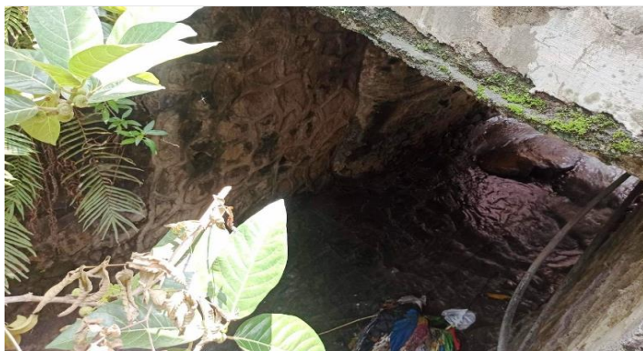
KONDISI BANGUNAN BAWAH
