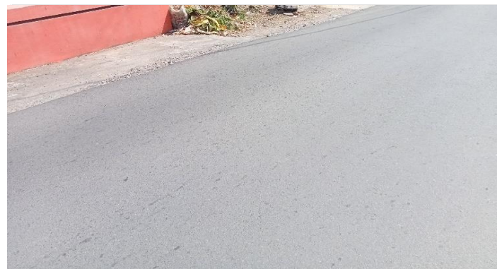
KONDISI LAPISAN PERMUKAAN LANTAI
