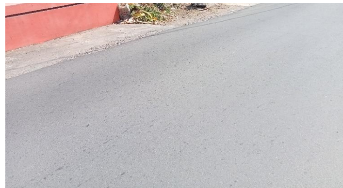
KONDISI LAPISAN PERMUKAAN LANTAI
