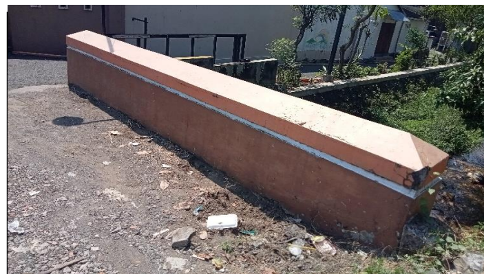
KONDISI SANDARAN / PARAPET
