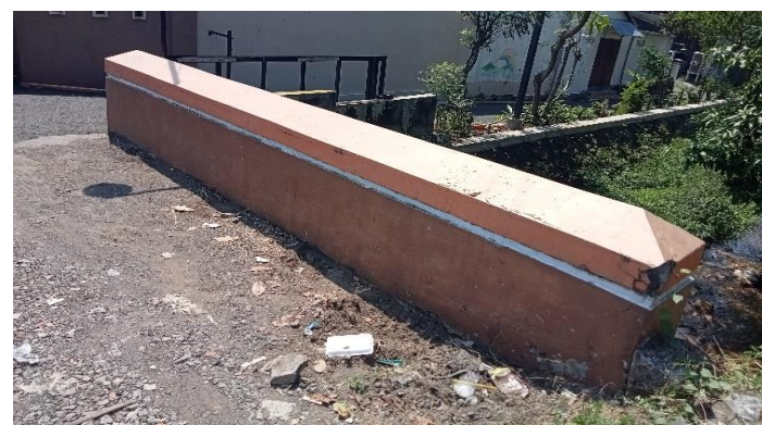
KONDISI SANDARAN / PARAPET
