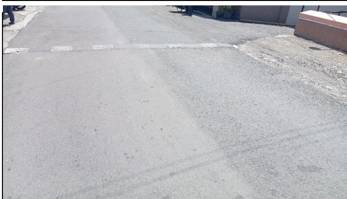
KONDISI LAPISAN PERMUKAAN LANTAI
