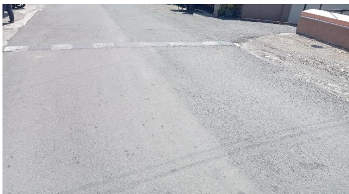
KONDISI LAPISAN PERMUKAAN LANTAI
