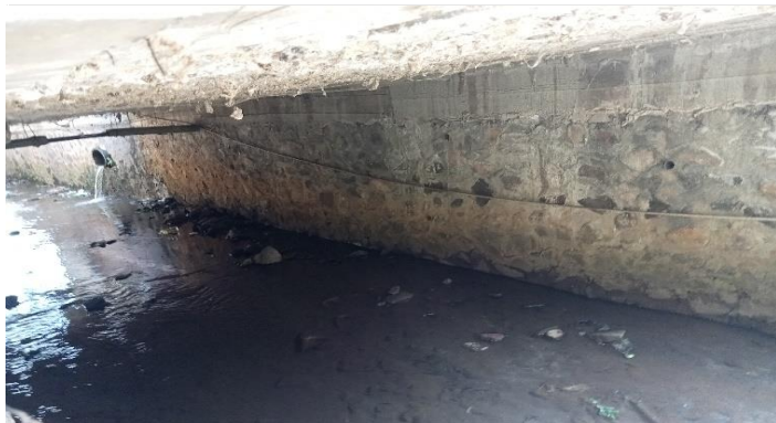
KONDISI BANGUNAN BAWAH
