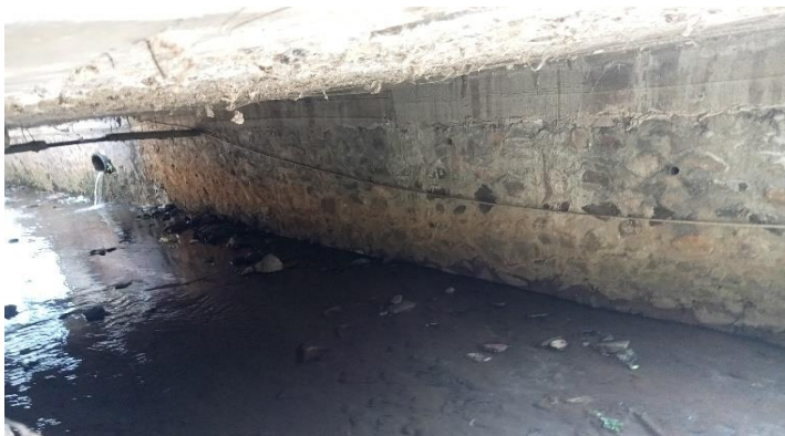
KONDISI BANGUNAN BAWAH
