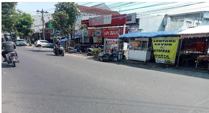
KONDISI LAPISAN PERMUKAAN LANTAI
