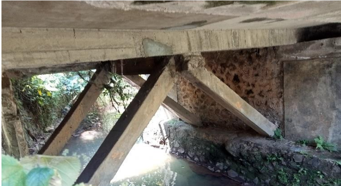
KONDISI BANGUNAN BAWAH
