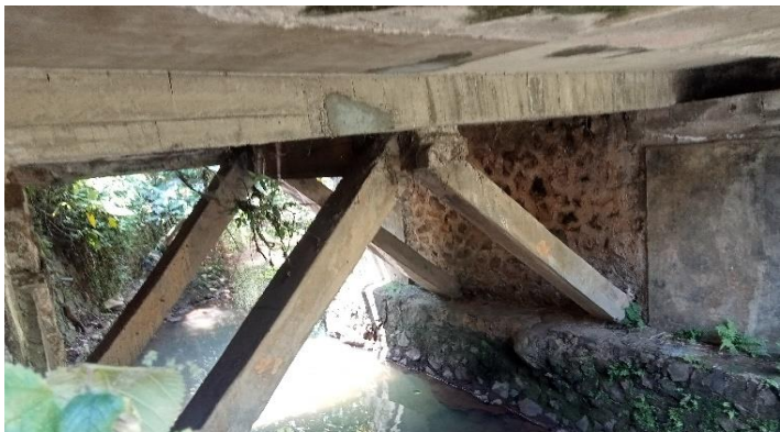
KONDISI BANGUNAN BAWAH
