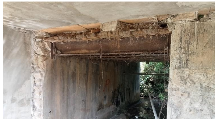
KONDISI BANGUNAN BAWAH
