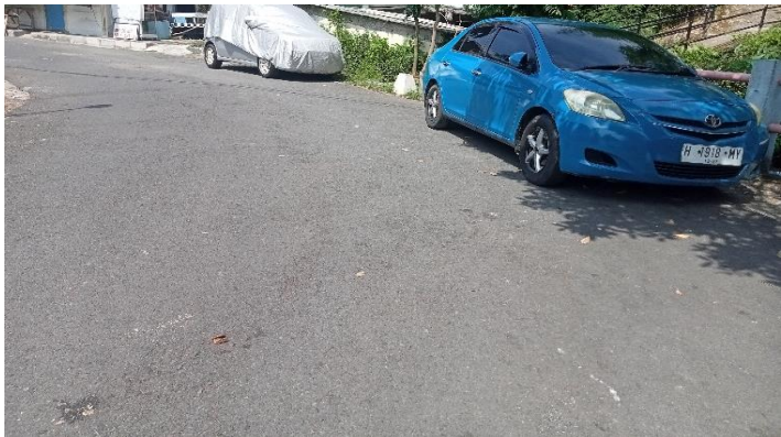
KONDISI LAPISAN PERMUKAAN LANTAI
