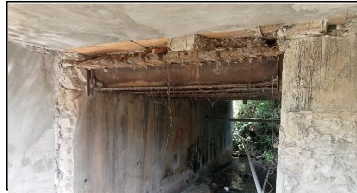
KONDISI BANGUNAN BAWAH
