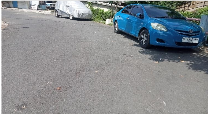
KONDISI LAPISAN PERMUKAAN LANTAI
