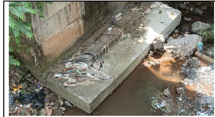
KONDISI PENGAMAN PONDASI
