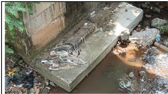
KONDISI PENGAMAN PONDASI
