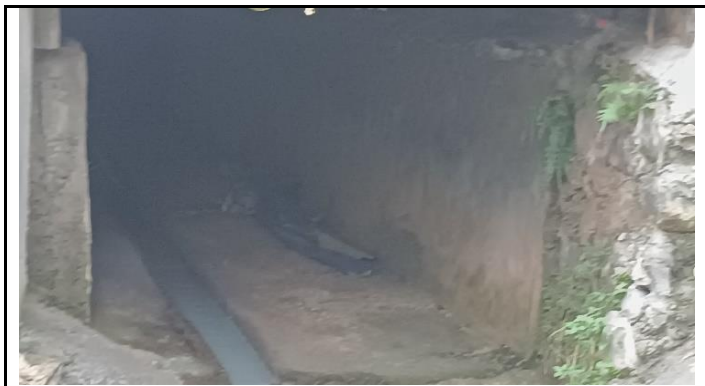
KONDISI BANGUNAN BAWAH
