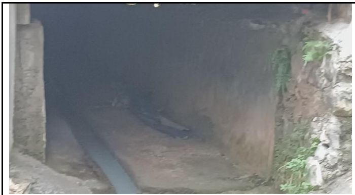
KONDISI BANGUNAN BAWAH
