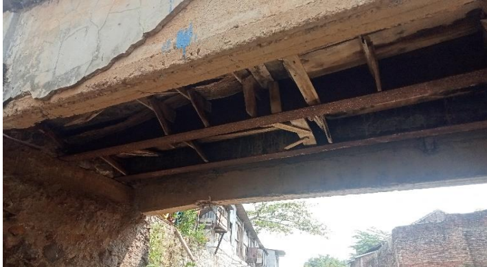
KONDISI BANGUNAN BAWAH
