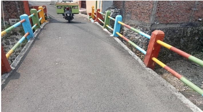
KONDISI LAPISAN PERMUKAAN LANTAI
