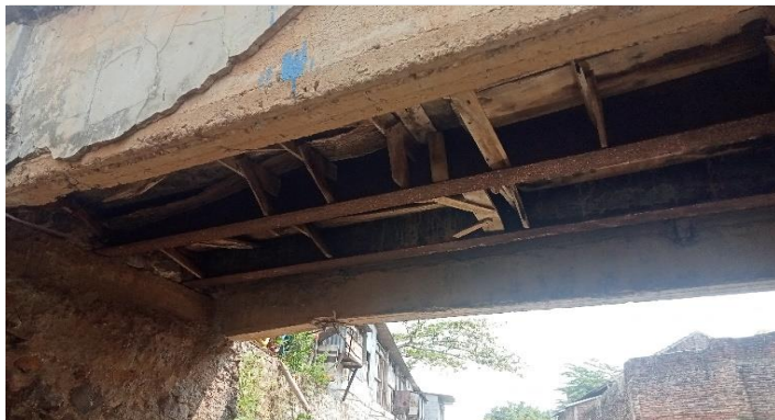
KONDISI BANGUNAN BAWAH
