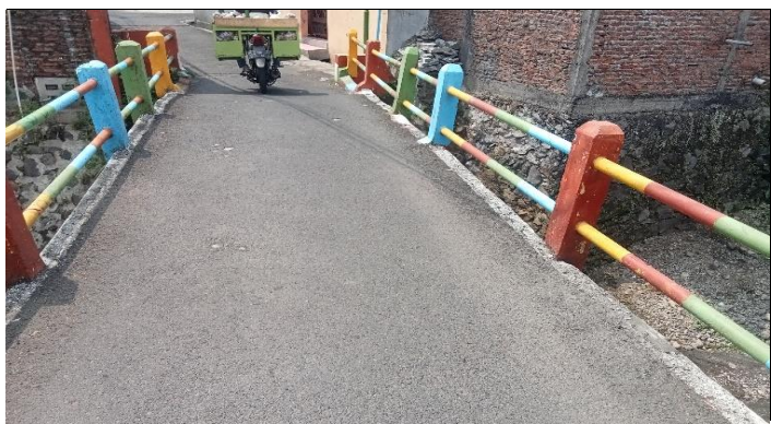
KONDISI LAPISAN PERMUKAAN LANTAI
