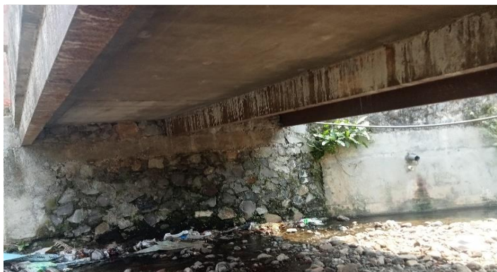
KONDISI BANGUNAN BAWAH
