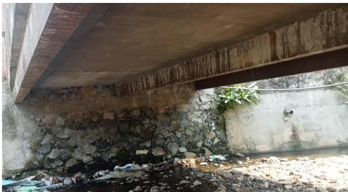
KONDISI BANGUNAN BAWAH
