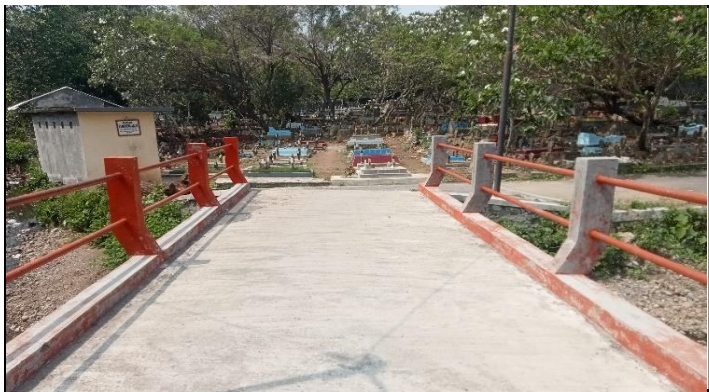
KONDISI LAPISAN PERMUKAAN LANTAI
