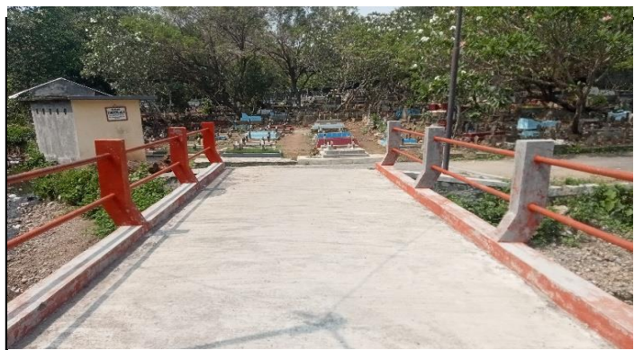
KONDISI LAPISAN PERMUKAAN LANTAI
