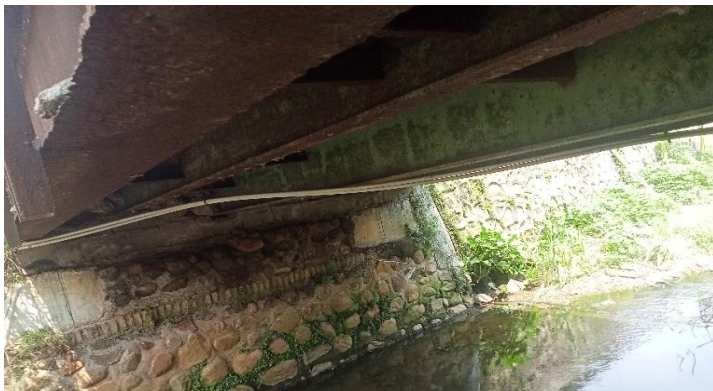
KONDISI BANGUNAN BAWAH
