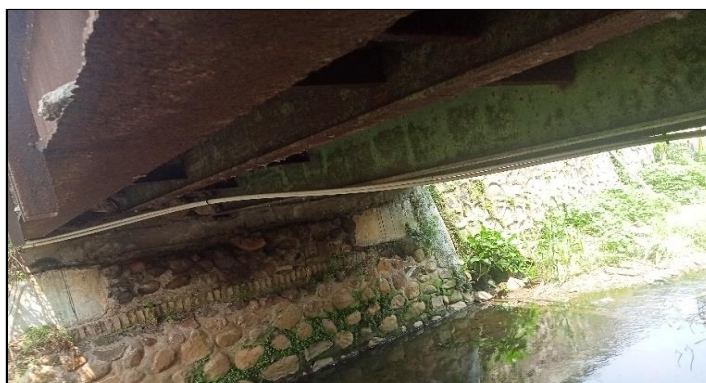
KONDISI BANGUNAN BAWAH
