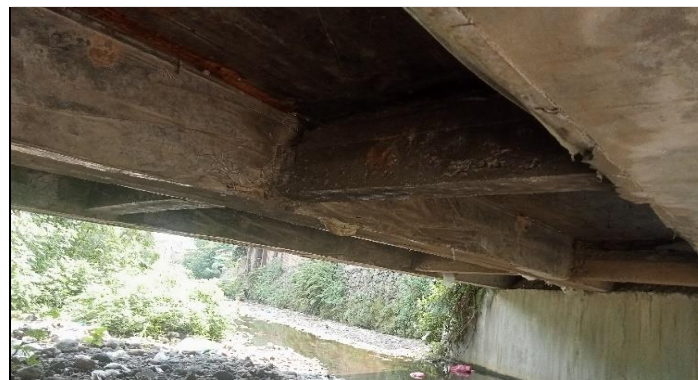
KONDISI BANGUNAN BAWAH
