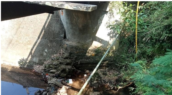
KONDISI BANGUNAN BAWAH
