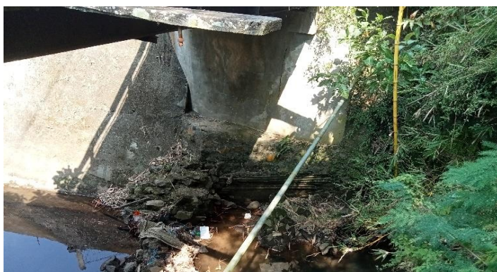
KONDISI BANGUNAN BAWAH
