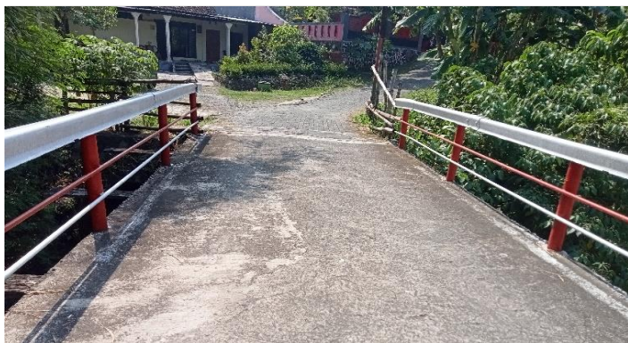
KONDISI LAPISAN PERMUKAAN LANTAI
