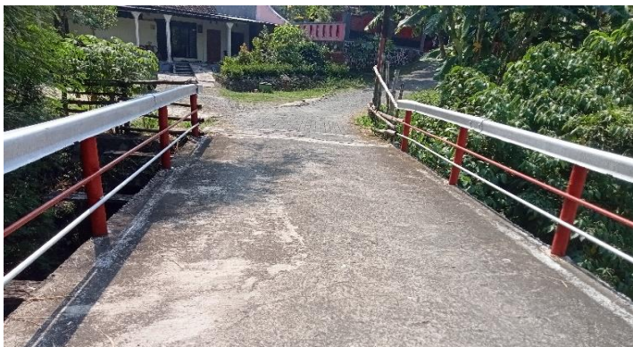
KONDISI LAPISAN PERMUKAAN LANTAI
