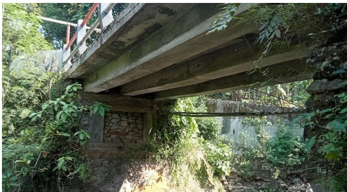
KONDISI BANGUNAN BAWAH
