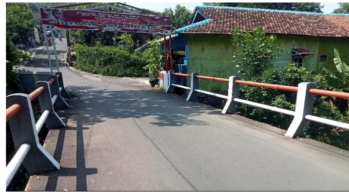
KONDISI LAPISAN PERMUKAAN LANTAI
