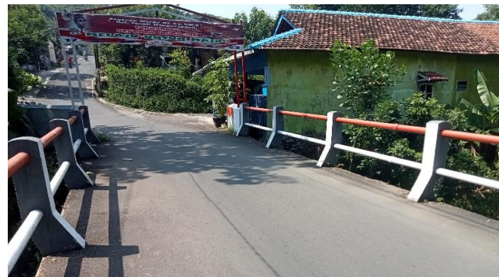
KONDISI LAPISAN PERMUKAAN LANTAI
