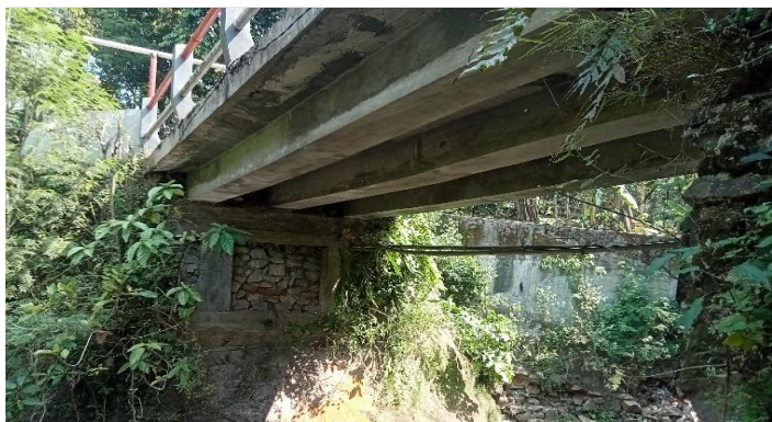
KONDISI BANGUNAN BAWAH
