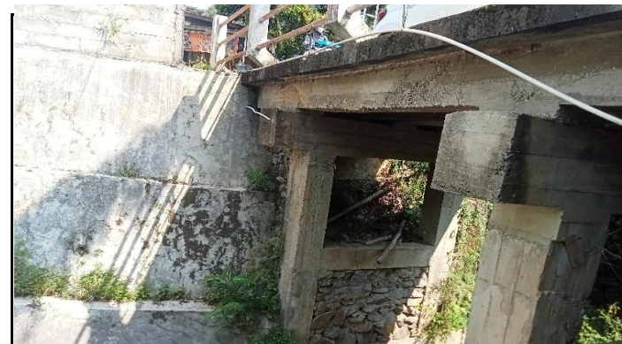
KONDISI BANGUNAN BAWAH
