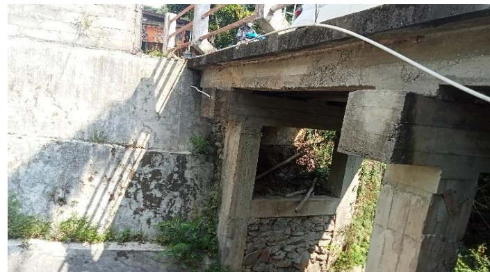
KONDISI BANGUNAN BAWAH
