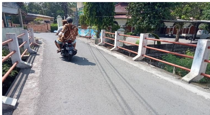
KONDISI LAPISAN PERMUKAAN LANTAI
