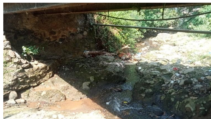
KONDISI BANGUNAN BAWAH
