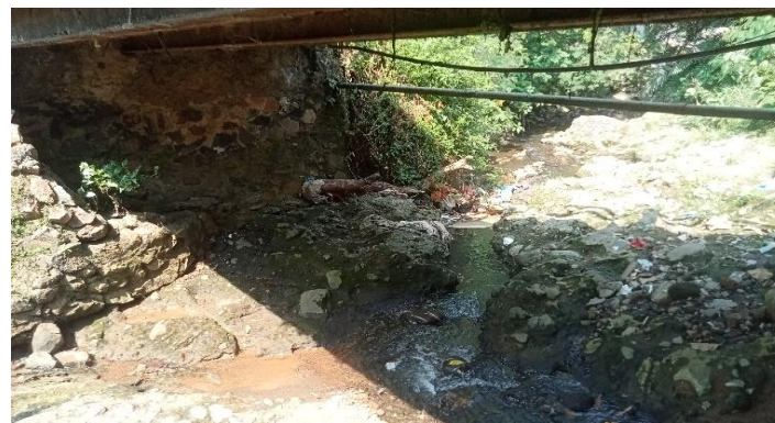
KONDISI BANGUNAN BAWAH
