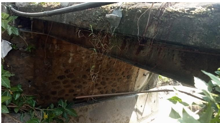
KONDISI BANGUNAN BAWAH
