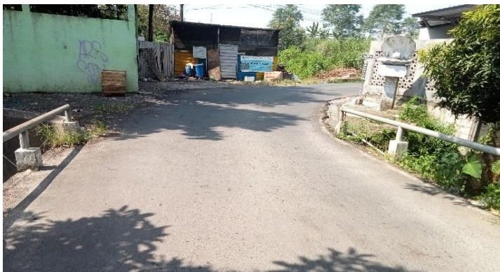
KONDISI LAPISAN PERMUKAAN LANTAI
