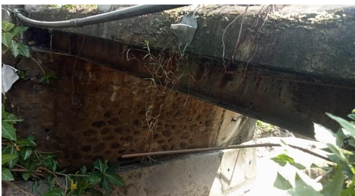
KONDISI BANGUNAN BAWAH
