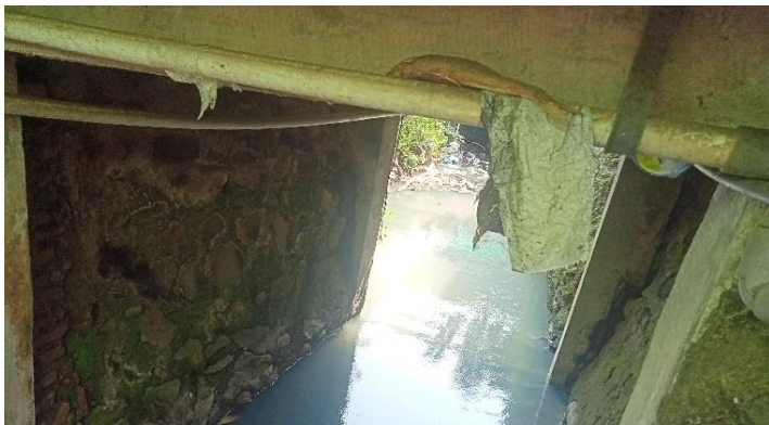
KONDISI BANGUNAN BAWAH
