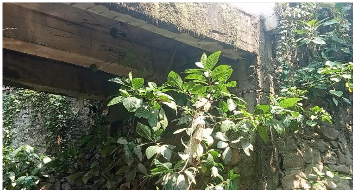
KONDISI BANGUNAN BAWAH
