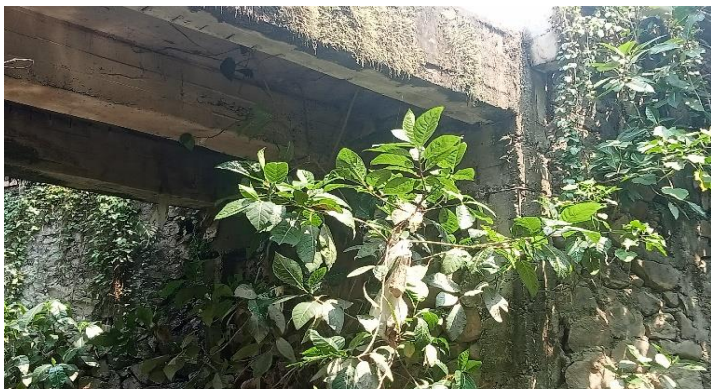
KONDISI BANGUNAN BAWAH
