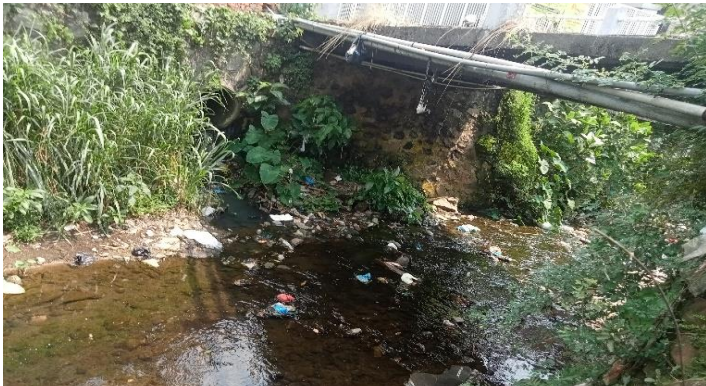
KONDISI BANGUNAN BAWAH
