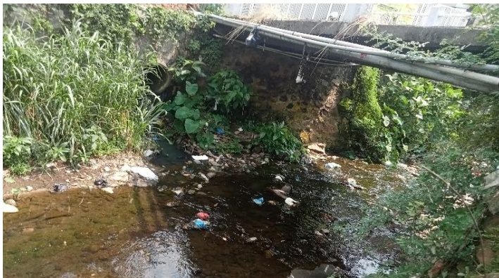
KONDISI BANGUNAN BAWAH
