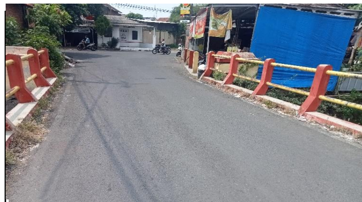
KONDISI LAPISAN PERMUKAAN LANTAI
