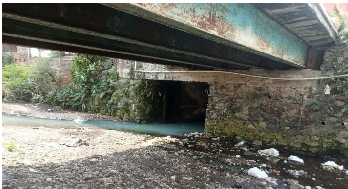
KONDISI BANGUNAN BAWAH
