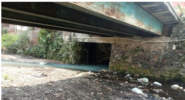
KONDISI BANGUNAN BAWAH
