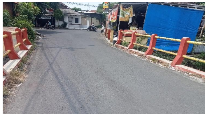
KONDISI LAPISAN PERMUKAAN LANTAI
