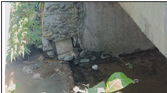
KONDISI BANGUNAN BAWAH
