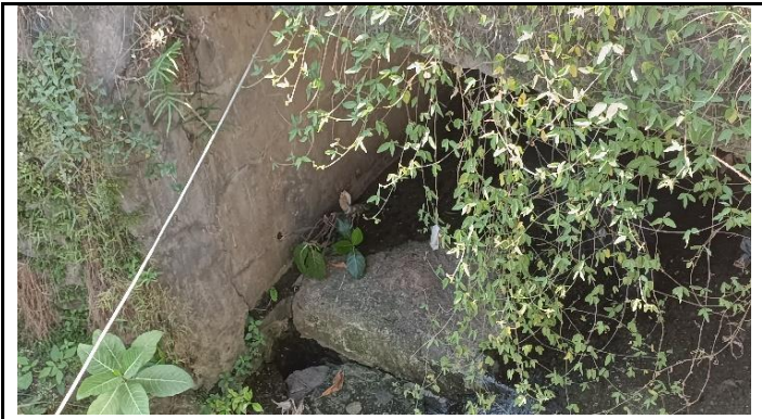
KONDISI BANGUNAN BAWAH
