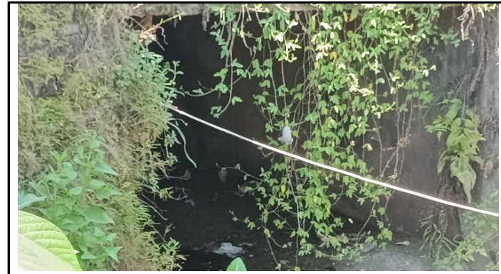
KONDISI BANGUNAN BAWAH
