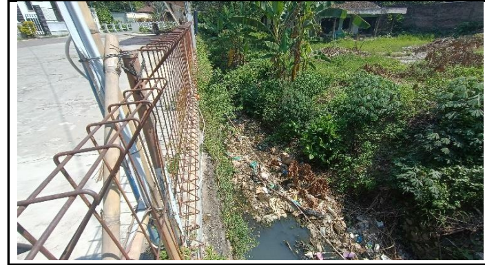
KONDISI ALIRAN SUNGAI PENUH SAMPAH
