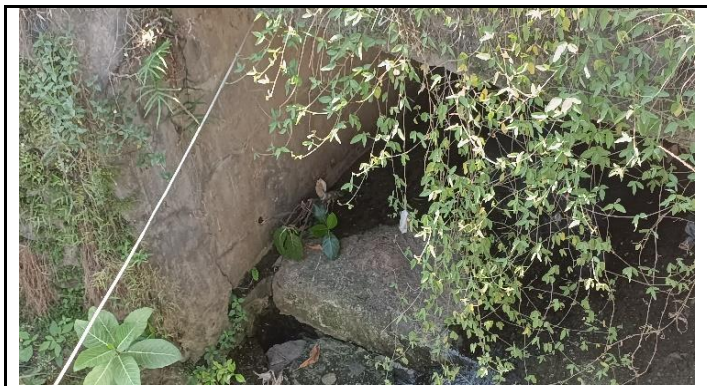
KONDISI BANGUNAN BAWAH
