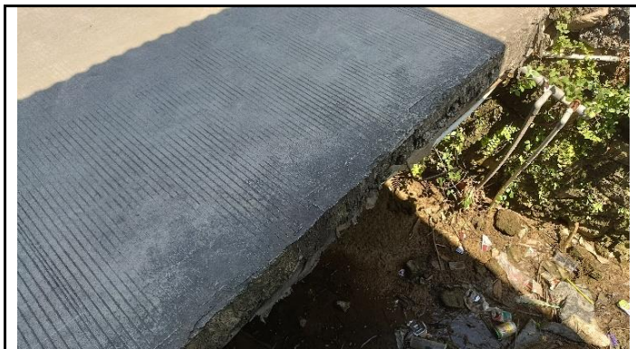
JEMBATAN TANPA SANDARAN
