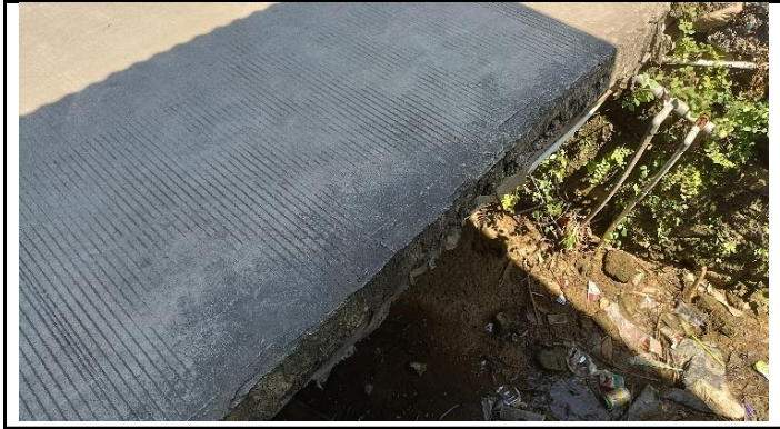
JEMBATAN TANPA SANDARAN
