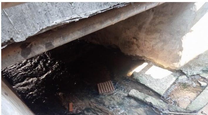
KONDISI BANGUNAN BAWAH
