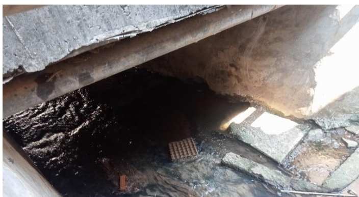
KONDISI BANGUNAN BAWAH
