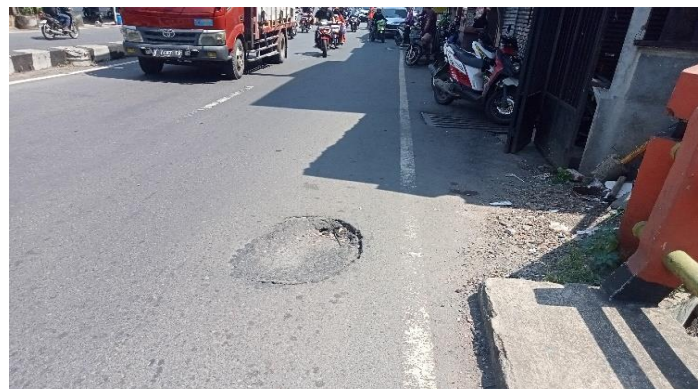
LAPISAN PERMUKAAN LANTAI BERLUBANG
