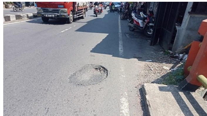
LAPISAN PERMUKAAN LANTAI BERLUBANG
