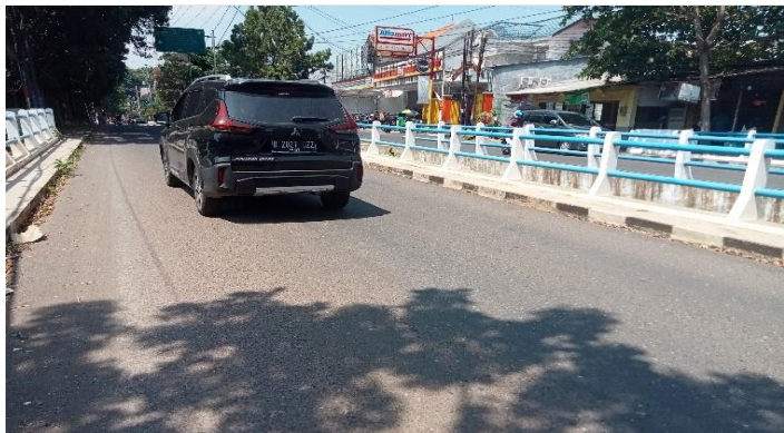
KONDISI LAPISAN PERMUKAAN LANTAI
