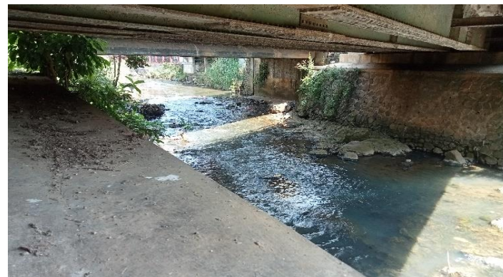
KONDISI BANGUNAN BAWAH
