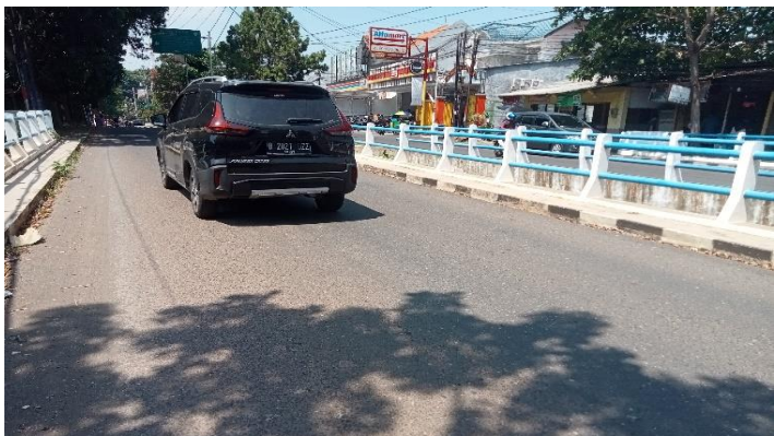
KONDISI LAPISAN PERMUKAAN LANTAI
