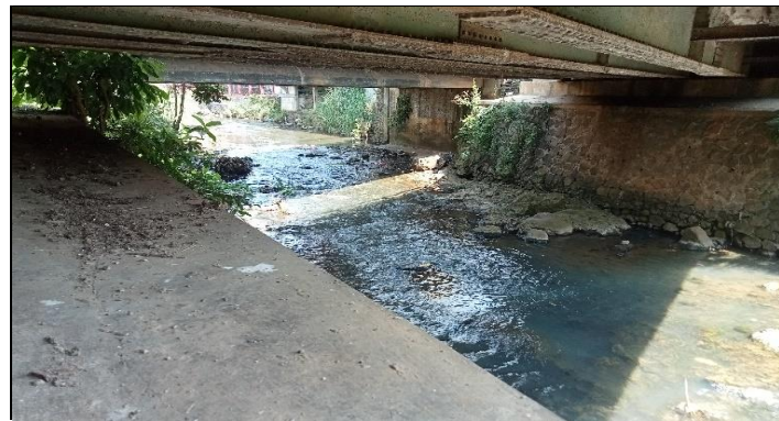
KONDISI BANGUNAN BAWAH
