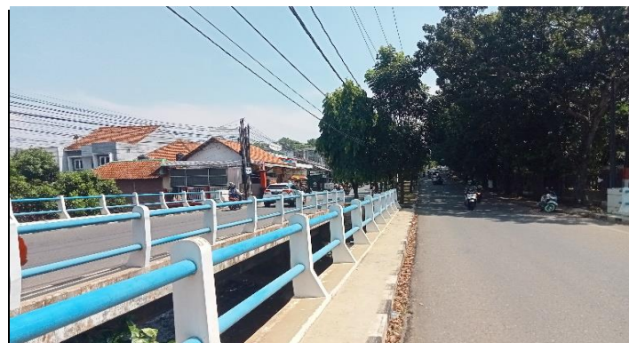
KONDISI SANDARAN DAN TROTOAR
