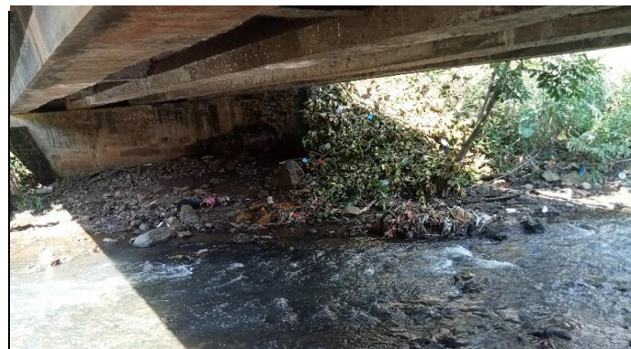
KONDISI BANGUNAN BAWAH
