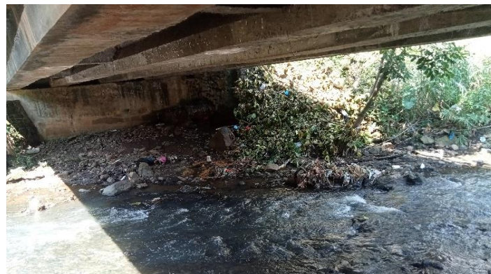
KONDISI BANGUNAN BAWAH
