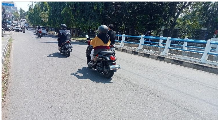
KONDISI LAPISAN PERMUKAAN LANTAI
