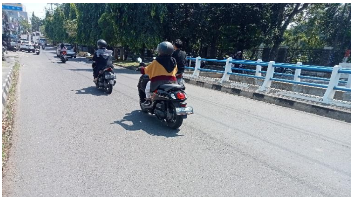
KONDISI LAPISAN PERMUKAAN LANTAI
