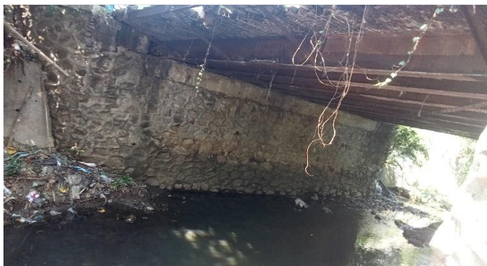
KONDISI BANGUNAN BAWAH
