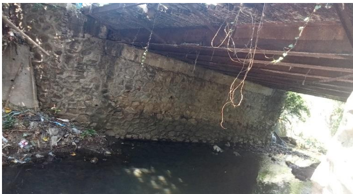
KONDISI BANGUNAN BAWAH
