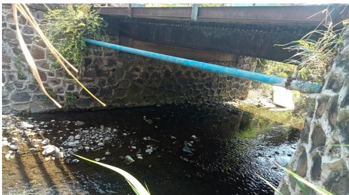
KONDISI BANGUNAN BAWAH
