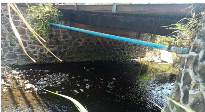
KONDISI BANGUNAN BAWAH
