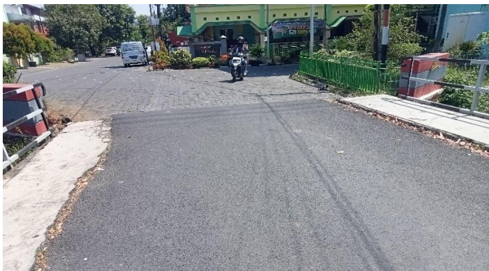
KONDISI LAPISAN PERMUKAAN LANTAI
