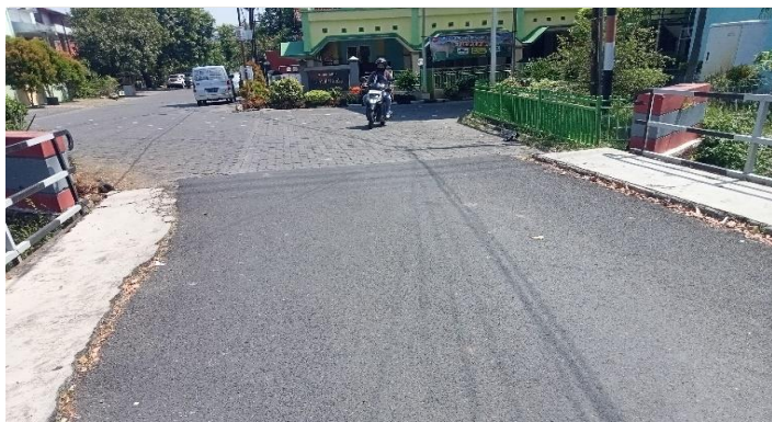
KONDISI LAPISAN PERMUKAAN LANTAI
