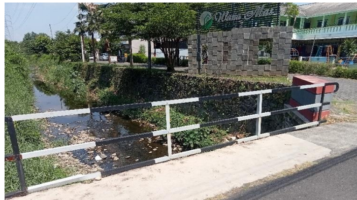
KONDISI SANDARAN DAN TROTOAR
