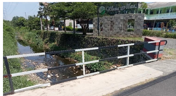
KONDISI SANDARAN DAN TROTOAR
