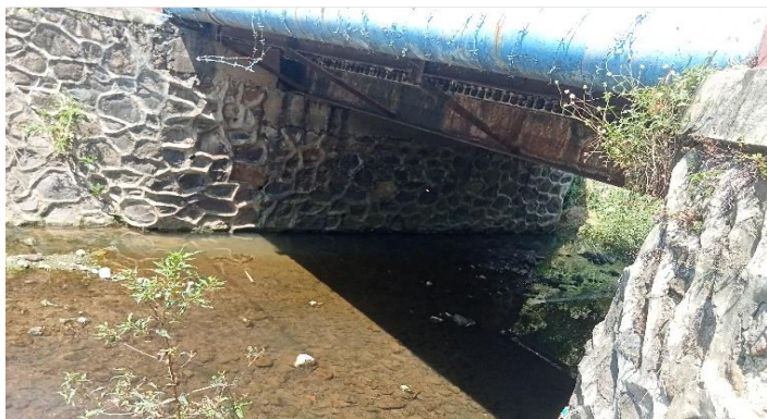
KONDISI BANGUNAN BAWAH
