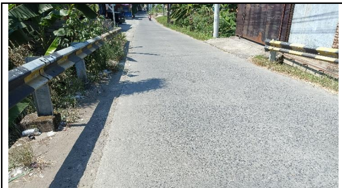
KONDISI JALAN PENDEKAT DAN PENGAMAN JALAN PENDEKAT
