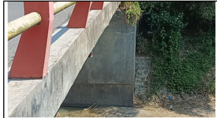
KONDISI KEPALA JEMBATAN
