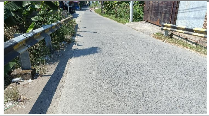
KONDISI JALAN PENDEKAT DAN PENGAMAN JALAN PENDEKAT
