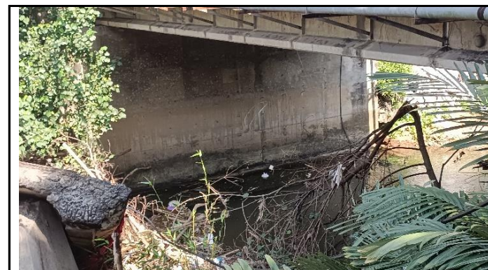
KONDISI GELAGAR PRATEKAN DAN KEPALA JEMBATAN
