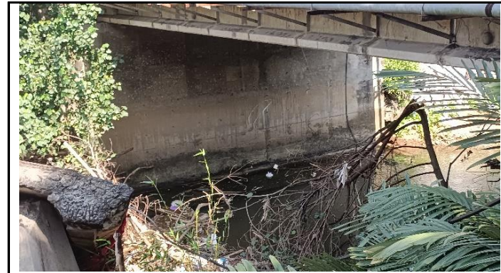
KONDISI GELAGAR PRATEKAN DAN KEPALA JEMBATAN
