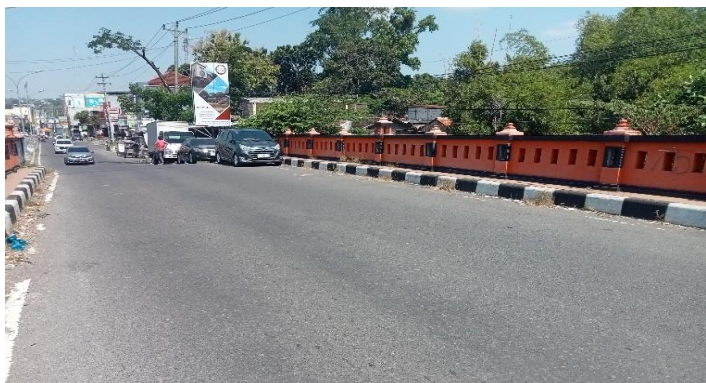
KONDISI LAPISAN PERMUKAAN LANTAI
