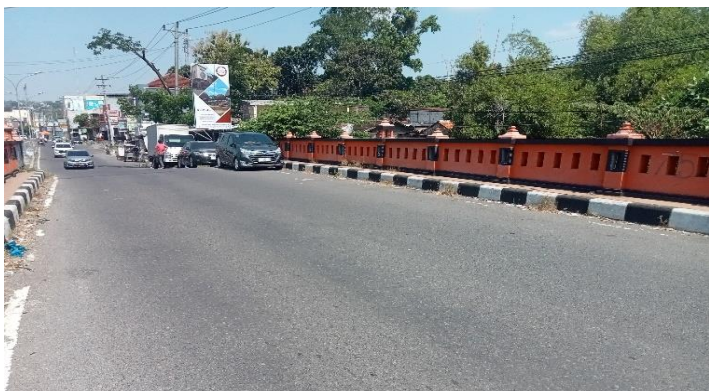
KONDISI LAPISAN PERMUKAAN LANTAI
