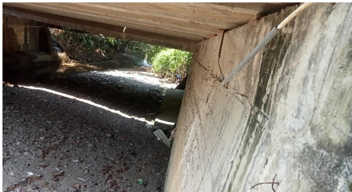
KONDISI BANGUNAN BAWAH
