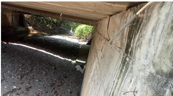
KONDISI BANGUNAN BAWAH
