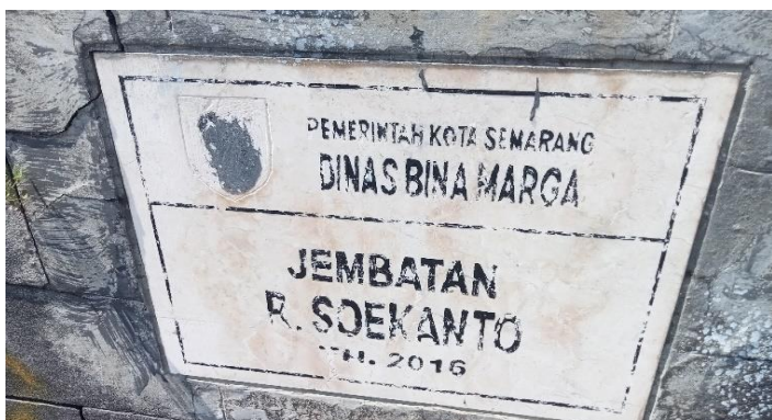
PAPAN NAMA JEMBATAN / PRASASTI
