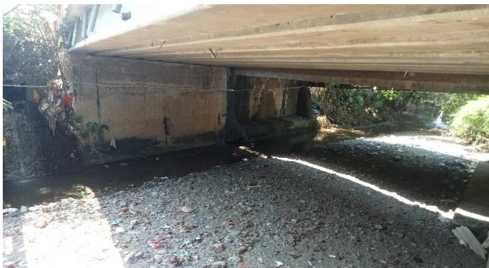
KONDISI BANGUNAN BAWAH
