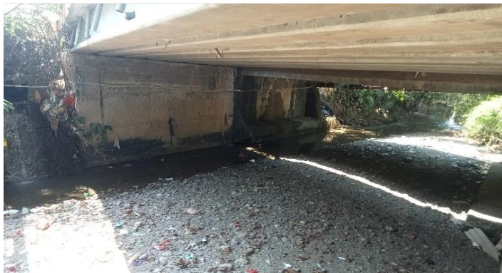
KONDISI BANGUNAN BAWAH
