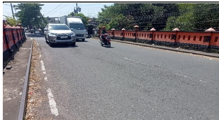
KONDISI LAPISAN PERMUKAAN LANTAI
