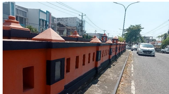
KONDISI SANDARAN DAN TROTOAR
