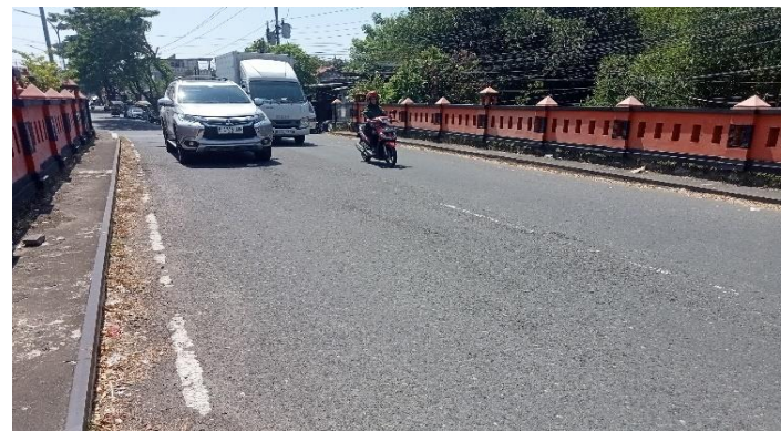
KONDISI LAPISAN PERMUKAAN LANTAI
