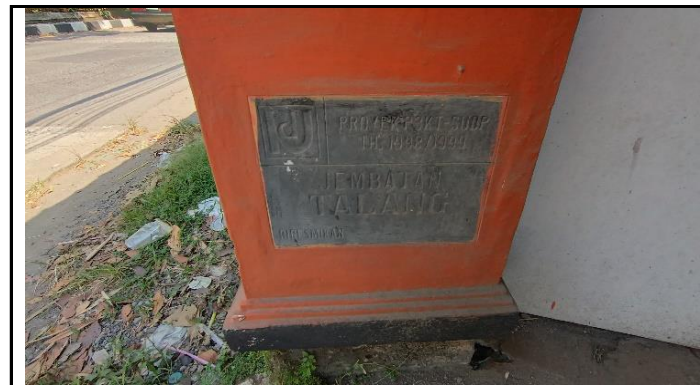
PAPAN NAMA JEMBATAN
