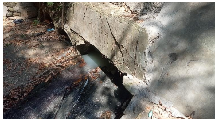
KONDISI BANGUNAN BAWAH
