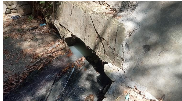
KONDISI BANGUNAN BAWAH
