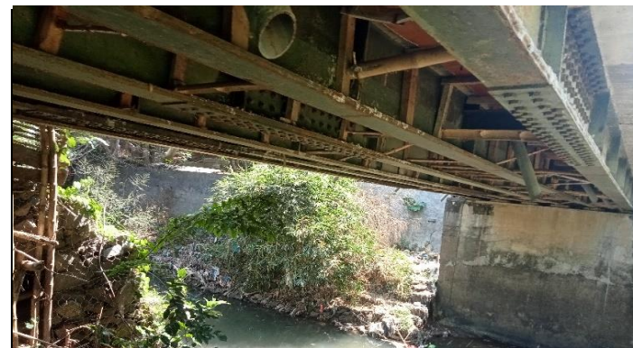
KONDISI BANGUNAN BAWAH
