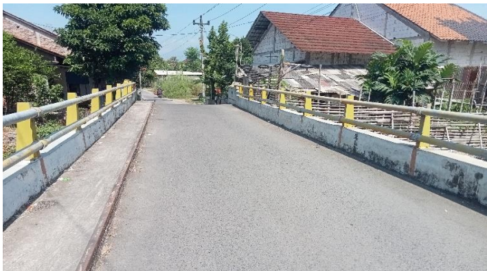
KONDISI LAPISAN PERMUKAAN LANTAI
