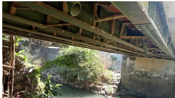
KONDISI BANGUNAN BAWAH
