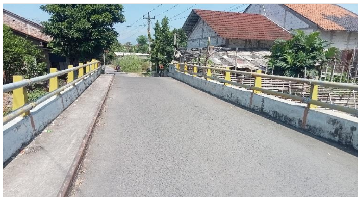
KONDISI LAPISAN PERMUKAAN LANTAI
