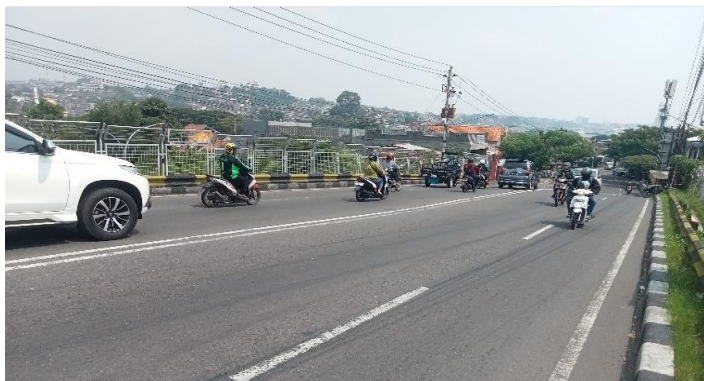
KONDISI LAPISAN PERMUKAAN LANTAI
