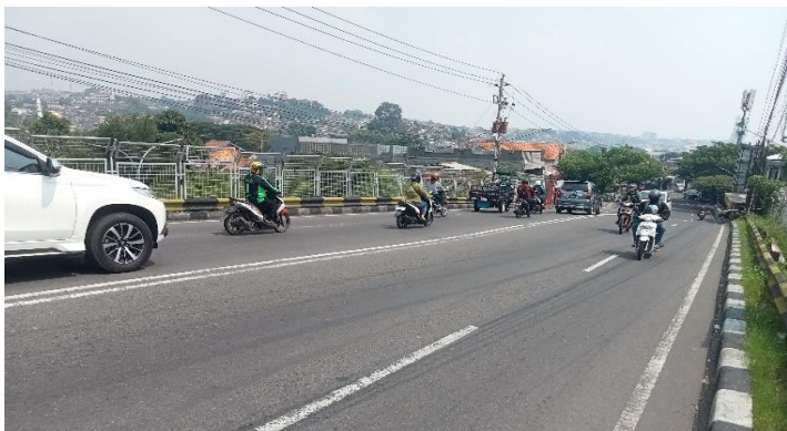
KONDISI LAPISAN PERMUKAAN LANTAI
