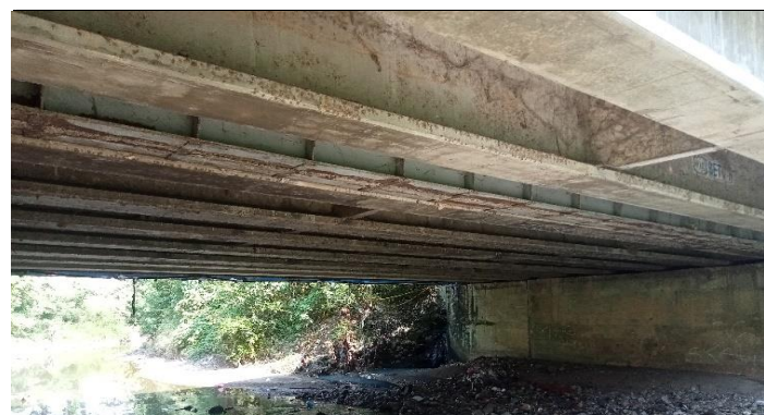
KONDISI BANGUNAN BAWAH
