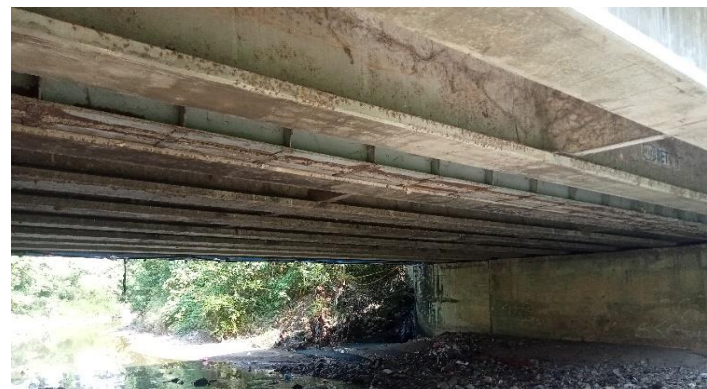
KONDISI BANGUNAN BAWAH
